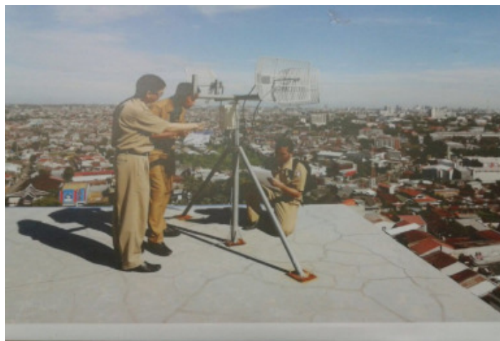
Gambar Pemasangan Pemancar Sumber: Data Primer, 2017.
